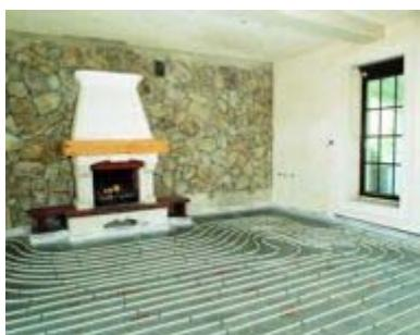
Труба PURMO Diffu - PEX изготовлена из сетчатого («сшитого») полиэтилена методом «а» (PE-Xa). Этот способ прошивки означает наивысшую эластичность среди сетчатых полипропиленов и обеспечивает высшую степень прошивки 80-85%.
